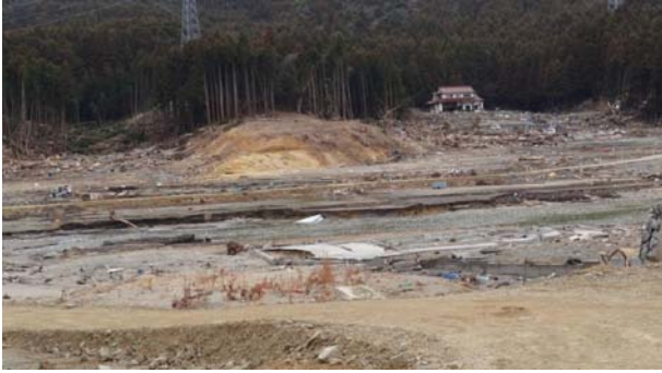
図17 牡鹿半島大谷川浜地区の被害.
